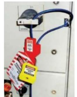
**Bloqueo Mecánico:** Gracias al cable que incorporan, bloquean varios elementos de la máquina o equipo al mismo tiempo: Disyuntores, válvulas, llaves de paso, etc.
